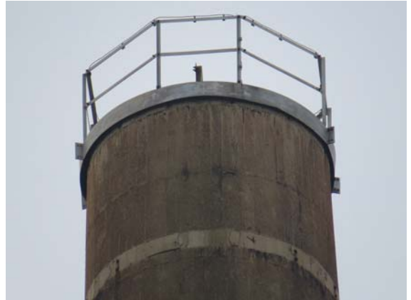
写真41 3号塔(頂上フェンス部)
