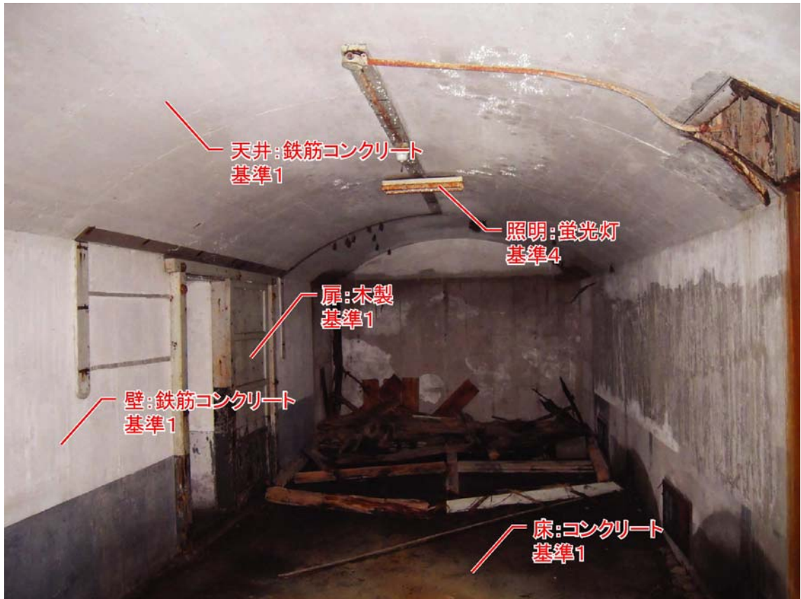
写真53 ⑥工業室、⑦油倉庫、⑧各科倉庫、⑩通路
