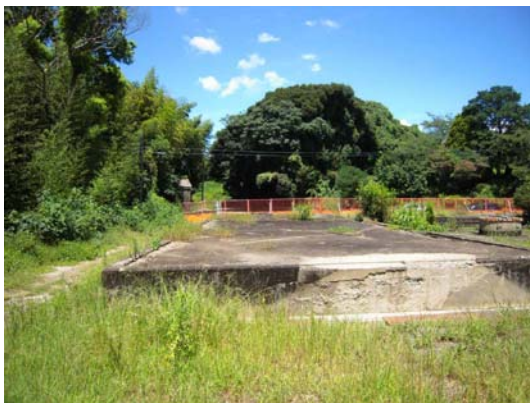
写真81 事務所及び兵舎基礎
