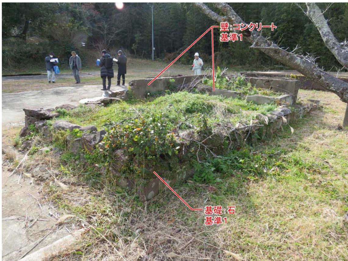
写真93 附属家基礎付近
