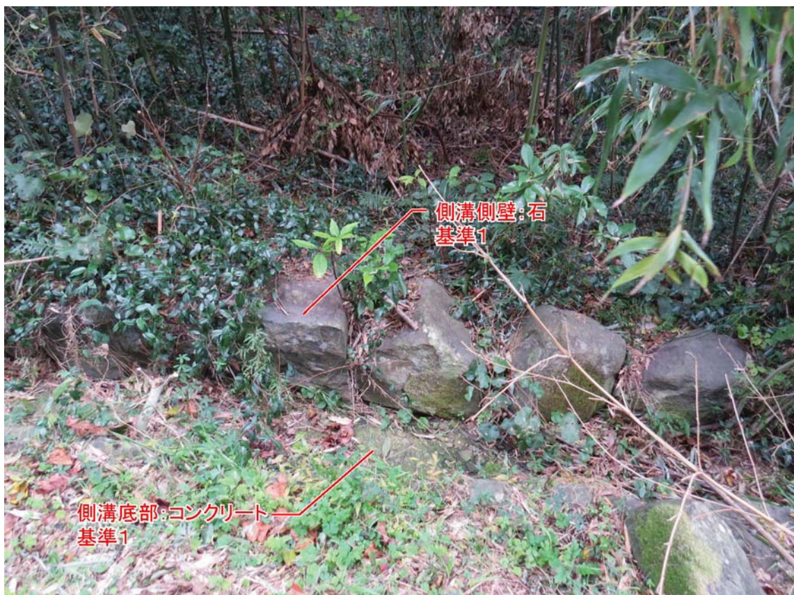
写真97 側溝(門柱付近)
