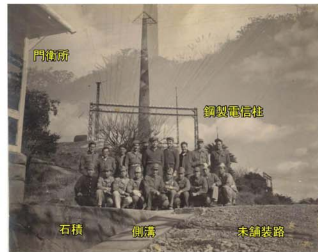
写真10 門衛所付近(牛島幸男氏提供) 人物の手前側に路面や側溝といったインフラの状況や門衛所の外観が部分的にわかる。奥側には現存しない鋼製電信柱が写っている。
