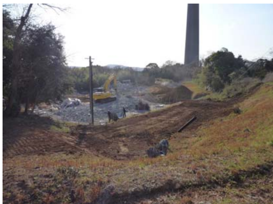
写真104 無線施設撤去の様子
