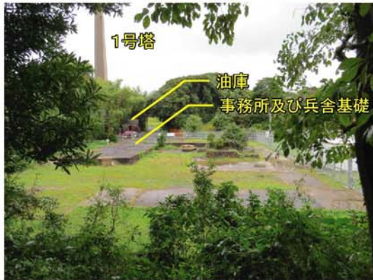
写真25 事務所及び兵舎基礎付近
