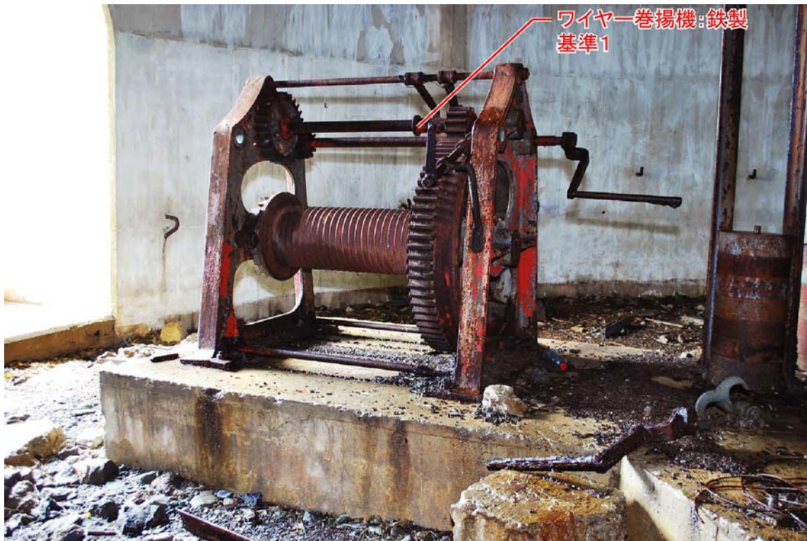
写真67 ワイヤー巻揚機(2号塔)
