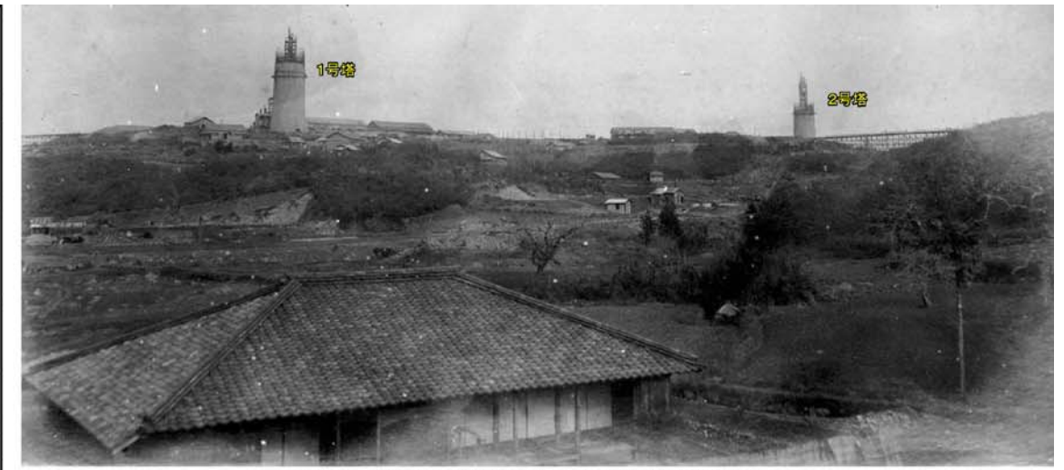
写真3 建設中の針尾送信所(清水建設株式会社提供)
