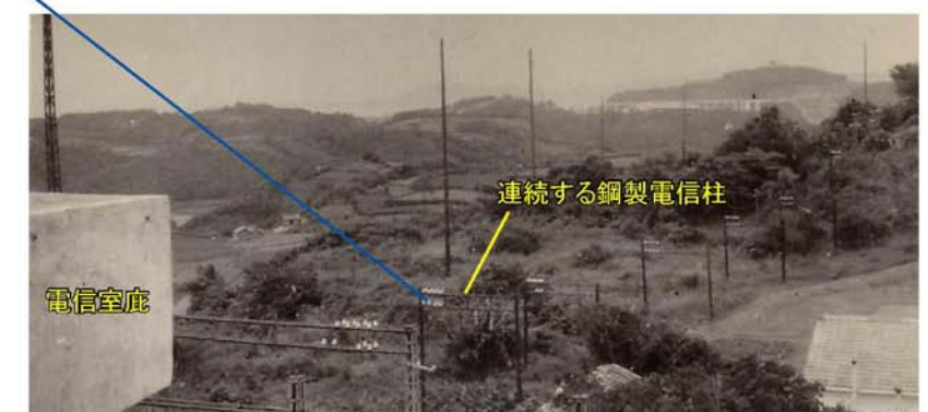
写真17 電信室南側の門型電柱(海上保安庁提供) 電信室から3号塔へ向かって鋼製電信柱が連続している。電信室の底も確認できる。
