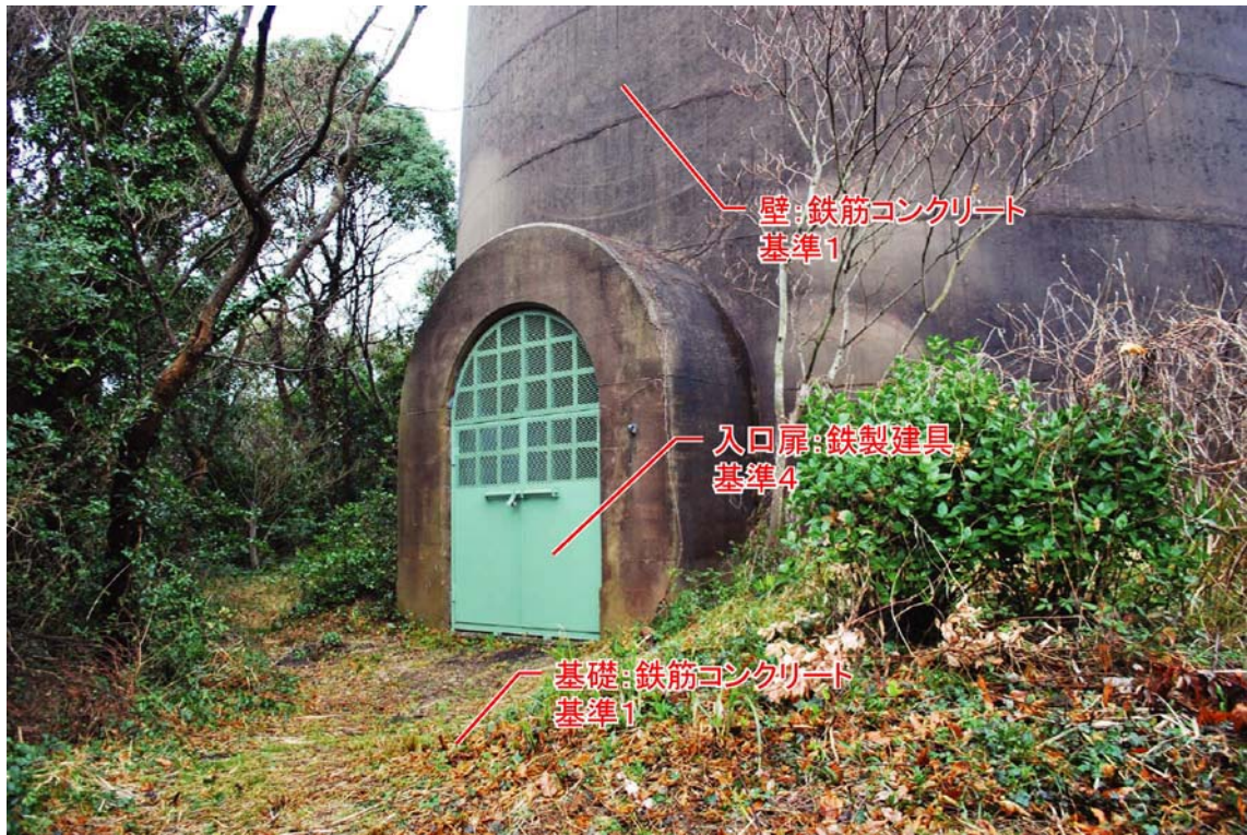
写真57 1号塔入口付近
