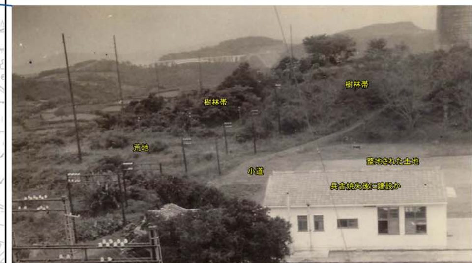
写真8 電信室から1号塔方面写真(海上保安庁提供) 門型電柱に沿って小道が見られるが、写真奥の樹林帯は現在より密度が低く、小道を通じて3号塔へ至ると考えられる。兵舎焼失後に建設されたと考えられる建物の向こう側には整地された土地が確認できる。この土地は当初図面ではテニスコートと記載がある。
