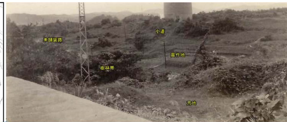
写真6 電信室から1号塔方面写真(海上保安庁提供) 棚田状になっているところは農作地であると考えられる。現在は樹林帯に埋もれて見えないものの、この時点では1号塔へ向かう小道が見られる。写真左奥には未舗装路がわずかに見える。
