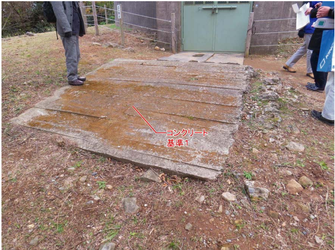
写真96 3号塔前コンクリート
