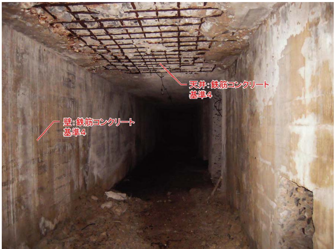
写真56 ⑫建物前面通路
