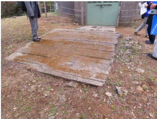
写真87 3号塔入口前コンクリート
