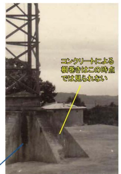
写真14 電信室上部(海上保安庁提供) 電信室中心部に建つ鋼製構造物の根元はコンクリート構造物により支えられている。後に補強のためさらに根巻きされているが、この写真撮影時点ではまだ施されていない。
