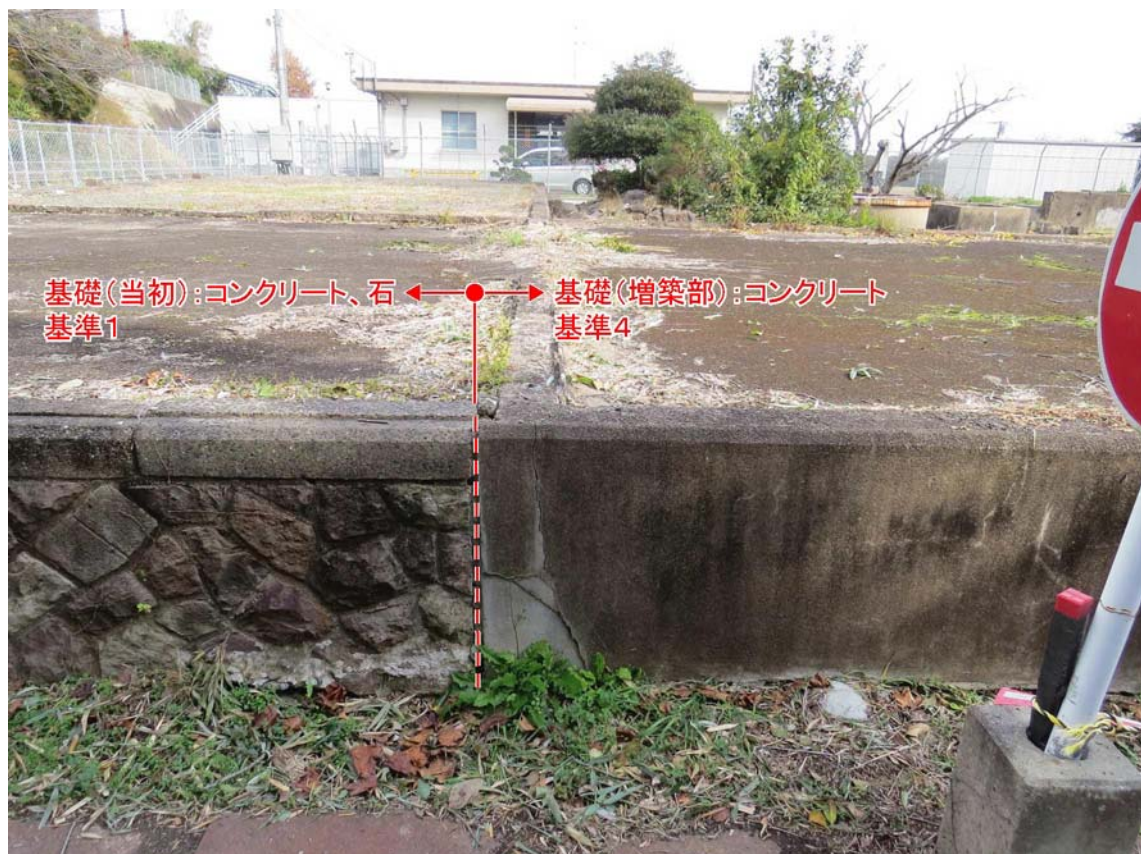
写真91 事務所及び兵舎基礎
