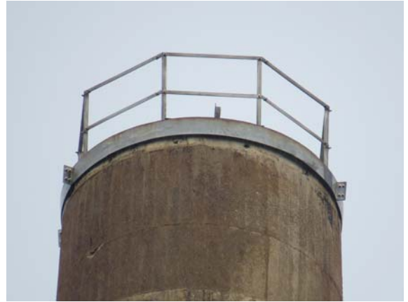
写真33 1号塔(頂上フェンス部)
