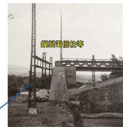
写真13 電信室東側(海上保安庁提供) 電信室東側には現存しない鋼製電信柱や用途不明の構造物がみられる。
