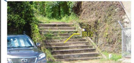
写真30 電信室前階段
