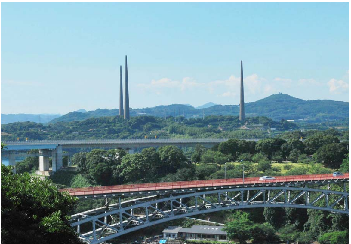
写真46 針尾送信所と西海橋
