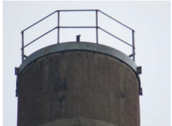
写真37 2号塔(頂上フェンス部)
