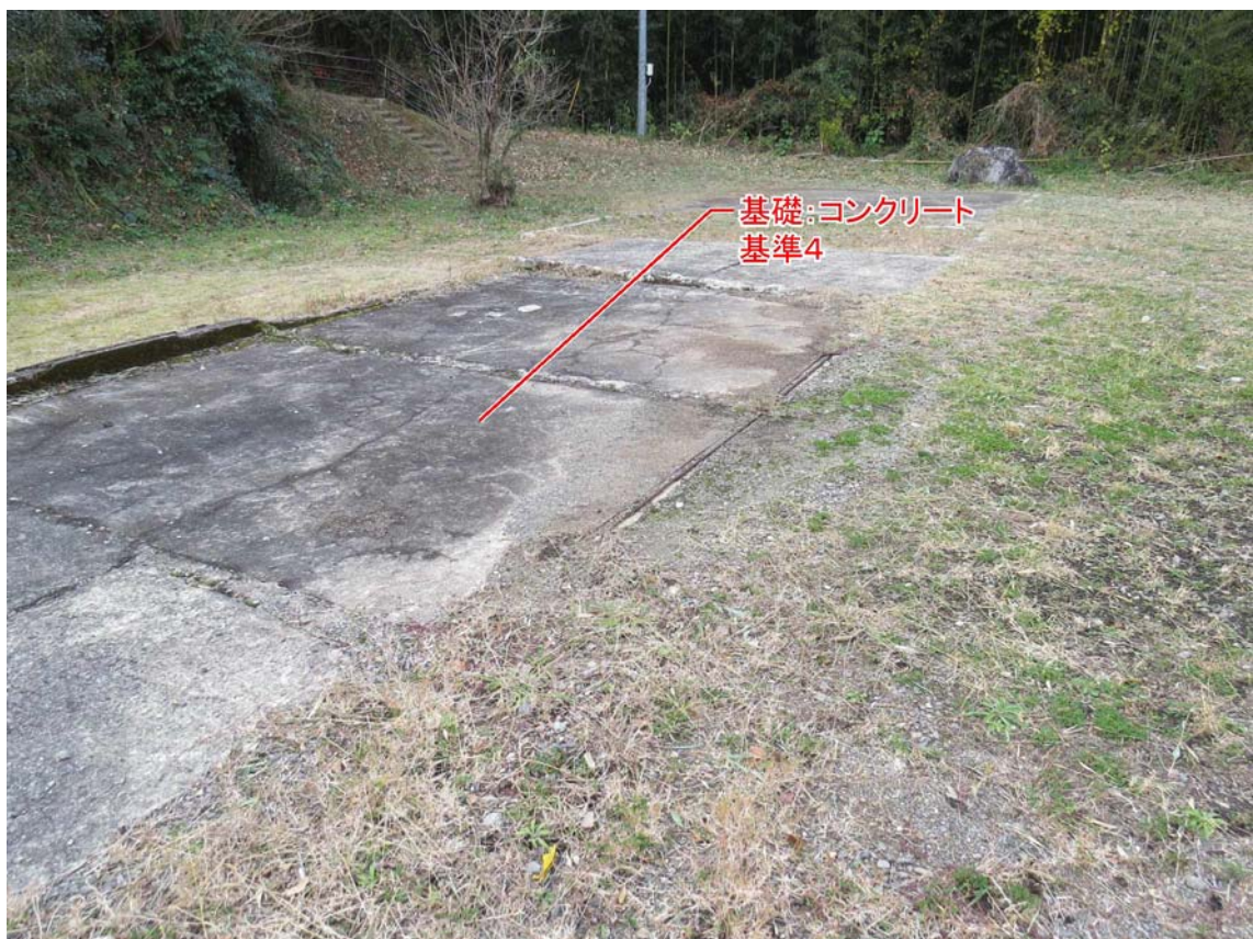
写真95 倉庫基礎付近
