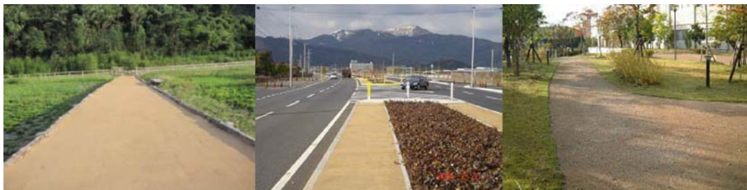
写真107 土系舗装(左、中)、木チップ舗装(右)<参考事例>
