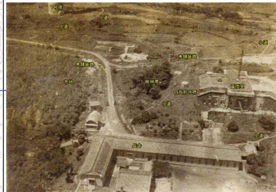
写真7 上空から兵舎付近(海上保安庁提供) 現在は敷地の多くが樹林帯となっているが、この時点では大部分が荒地で見通しが良い。上空から見ると未舗装路や小道の様子がわかる。未舗装路から1号塔へ向かう小道や、兵舎から電信室前を通る小道、門衛所から10t水槽へ向かう小道などから、かなり自由に敷地内を移動できたと考えられる。
