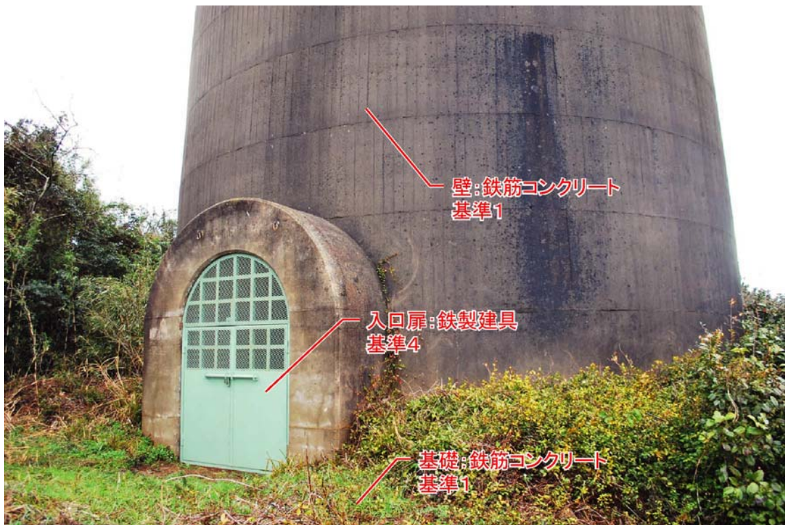
写真63 2号塔入口付近
