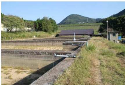
写真108 山の田浄水場 (北部ブロック)
