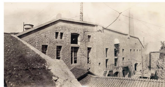
電信室建設時の写真
